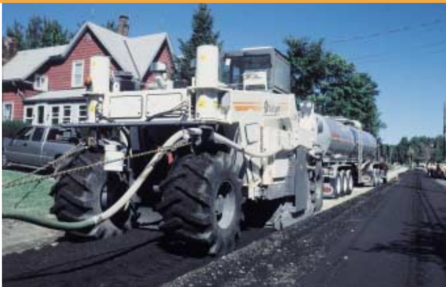
WR 2500 foam stabilizes S. R. 8 in Maine
